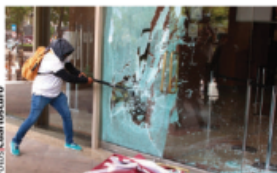
VANDALISMO en la Torre del Bienestar.
