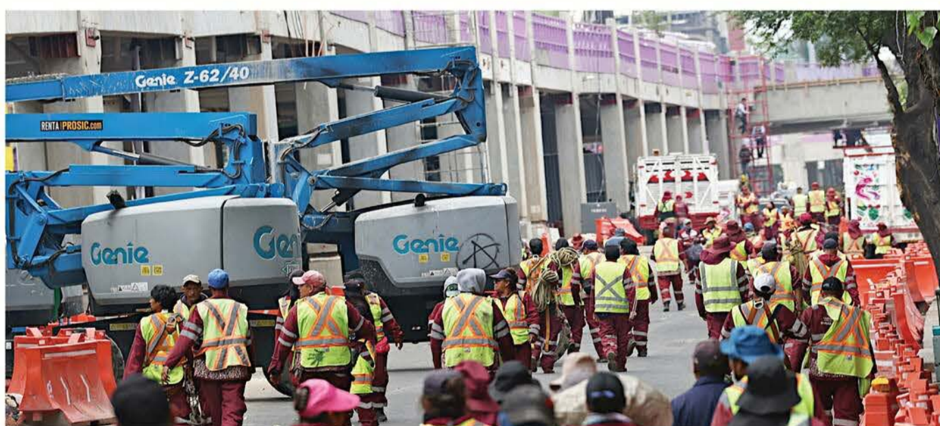
■ Aspecto de las obras en Chabacano y San Antonio en dirección el Centro Histórico.
