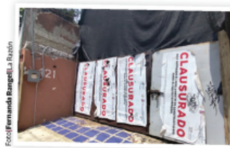
AVISO de suspensión en la obra, ayer.
