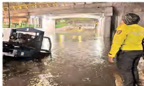
El bajopuente de Viaducto Río de la Piedad y Churubusco se inundó, pero no quedaron vehículos varados en el sitio.
