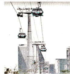
La nueva línea tiene una extensión de 5.4 Km.
