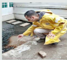
Autoridades hallaron combustible derramado en las viviendas.
