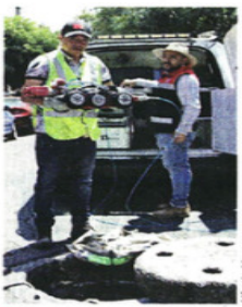
Personal aún realiza labores en el lugar.
