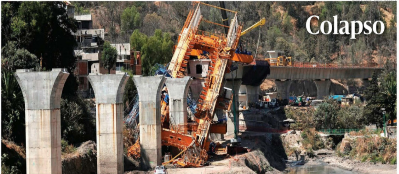
Una grúa o "lanzadora de dovelas" de alrededor de más de 200 metros y de alrededor de 800 toneladas se desplomó la madrugada del miércoles durante una maniobra de desplazamiento de dovelas en el tramo Presa Tacubaya - Terminal Observatorio del Tren Interurbano. PAG 13
