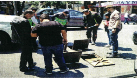
Además del análisis de la calidad de agua, se realiza desazolve del drenaje.
