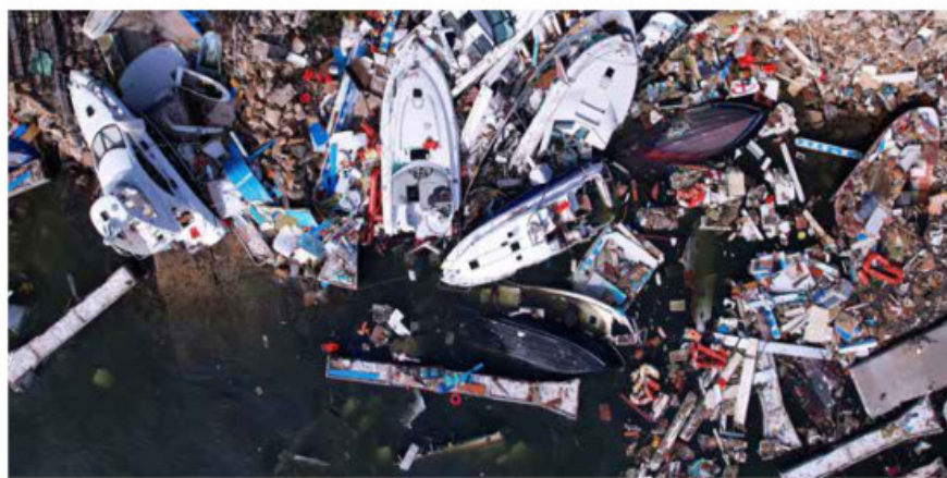
El embate del huracán Otis generó daños estructurales al puerto de Acapulco, como la destrucción del Club de Yates. (Foto: EFE) ▶ 12
