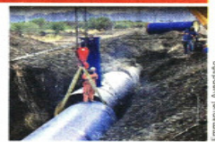
A 4 días de "inaugurado", el acueducto sigue en obras.
