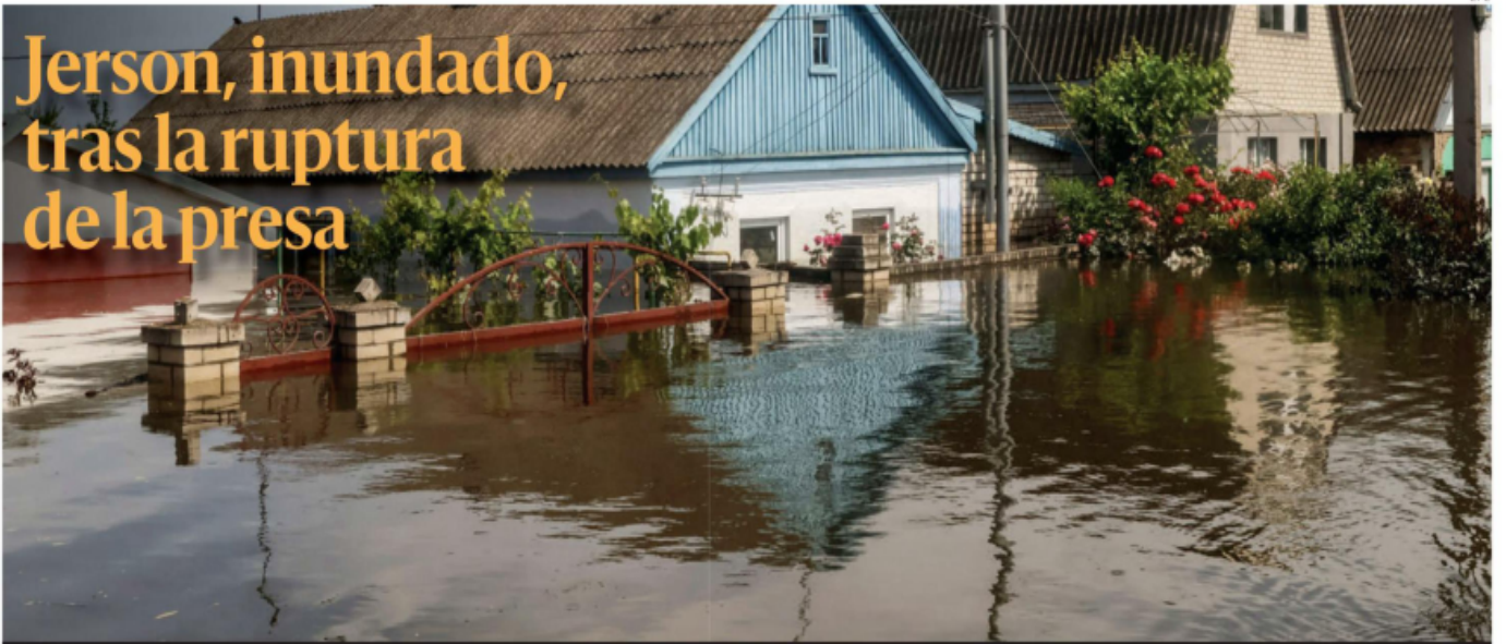
Calle inundada en el pueblo de Sadove, región de Jerson, Ucrania, donde fueron destruidas una importante presa y una central hidroeléctrica en el río Dnipro. El gobierno de Ucrania acusa a Rusia de la voladura.
